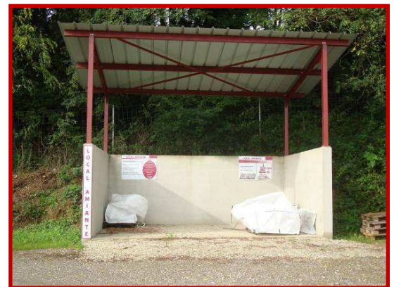
- Le local à amiante sur la plateforme de gravats à côté de la déchetterie de Rumilly -
